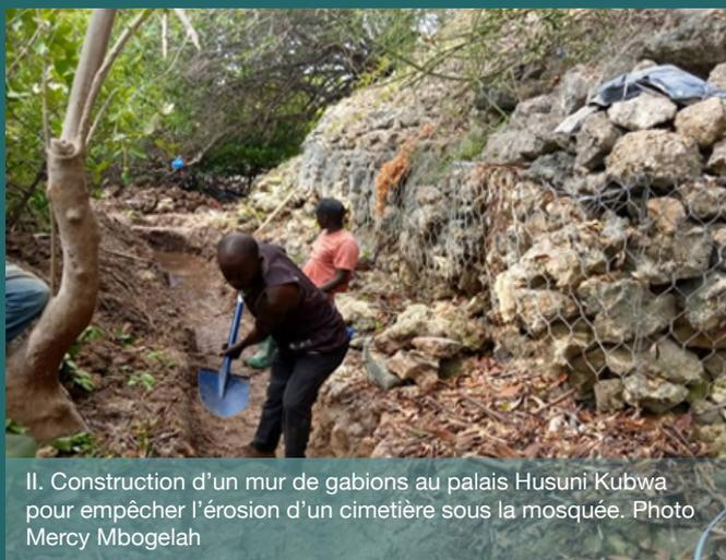
II. Construction d'un mur de gabions au palais Husuni Kubwa pour empêcher l'érosion d'un cimetière sous la mosquée. Photo Mercy Mbogelah
