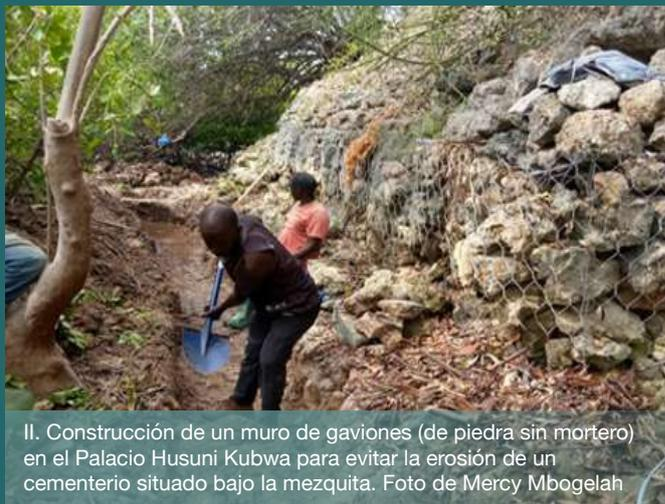
II. Construcción de un muro de gaviones (de piedra sin mortero) en el Palacio Husuni Kubwa para evitar la erosión de un cementerio situado bajo la mezquita. Foto de Mercy Mbogelah
